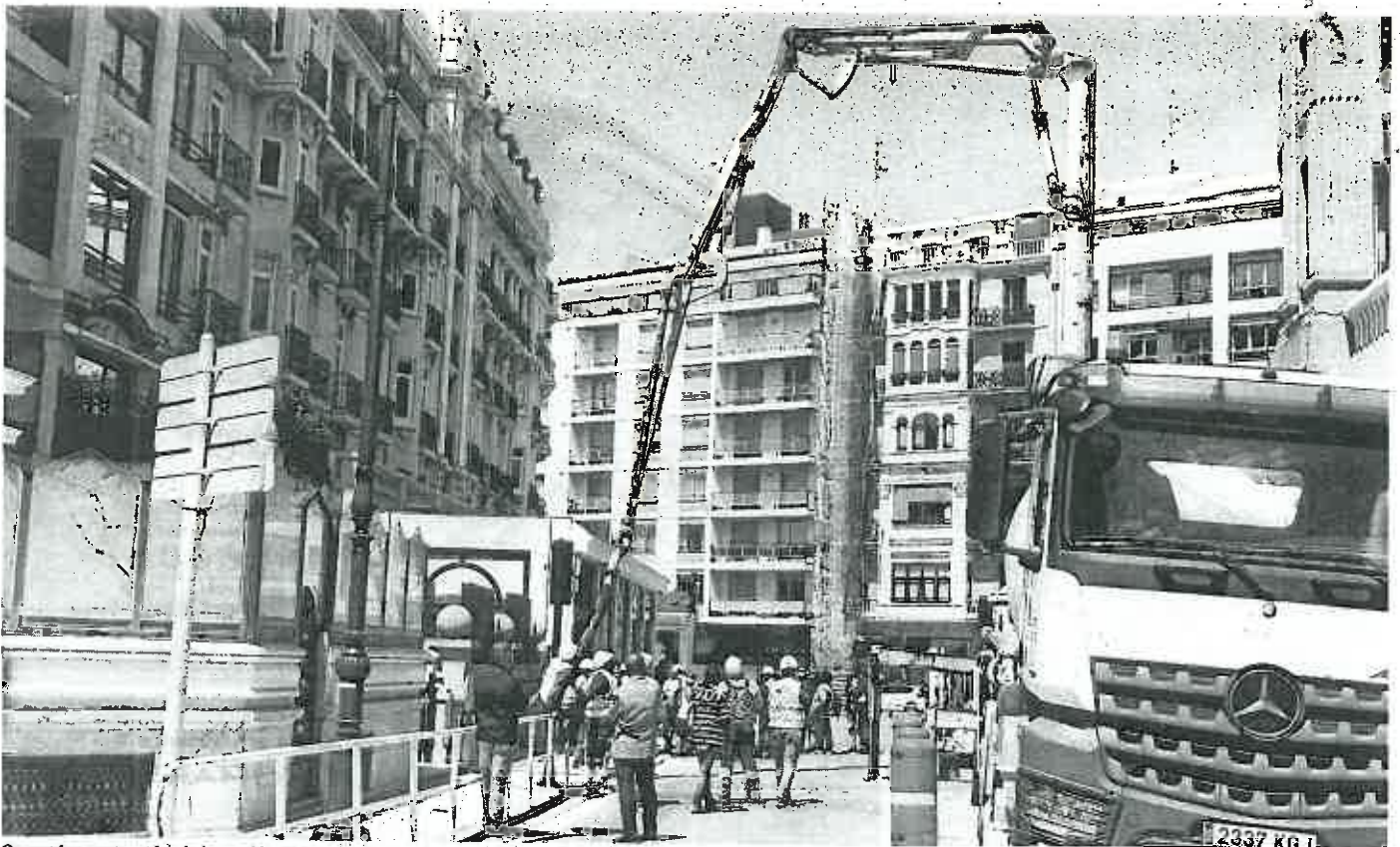
Operarios contemplan la inyección de hormigón para taponar el hueco del sótano.
